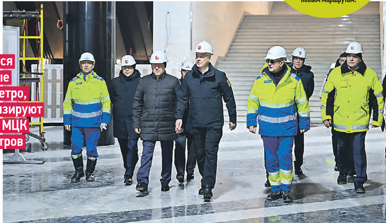
29 января. Мэр Москвы Сергей Собянин (в центре) осматривает ход строительства станции метро «Генерала Тюленева»
