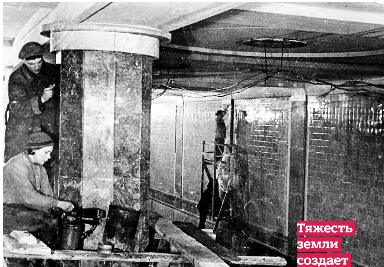
24 августа 1934 года. Рабочие ведут облицовочные работы в вестибюле станции метро «Красносельская»
