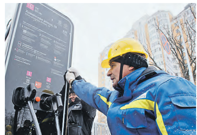
8 декабря 2022 года. Установка электрической зарядной станции у Хованского въезда на ВДНХ
