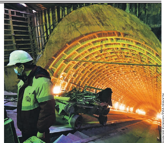
12 марта 2021 года. Строительство самой глубокой станции метро «Марьина Роща»
