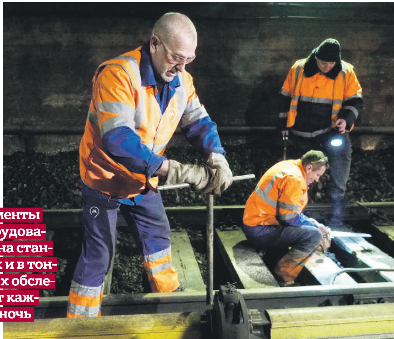
18 февраля 2019 года. Рабочие проводят плановый ремонт путей на Сокольнической линии Московского метрополитена в ночное время
