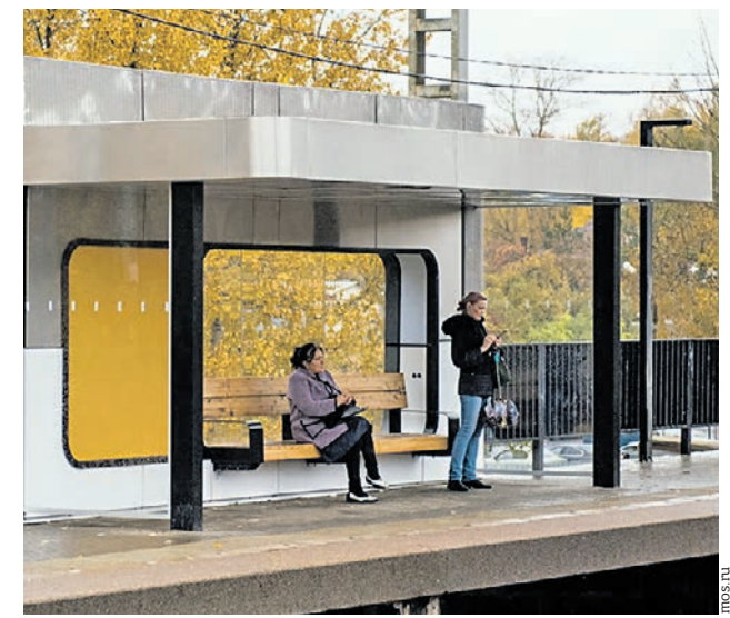
15 октября 2019 года. На станции Хлебниково отремонтировали кассу и установили погодные модули
