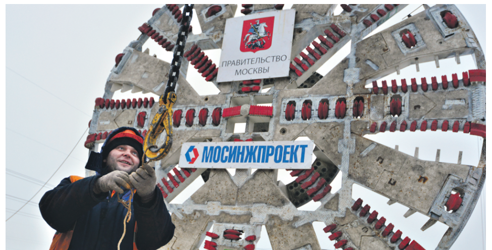
23 декабря 2016 года. Монтаж ротора 10-метрового проходческого щита «Лилия»
