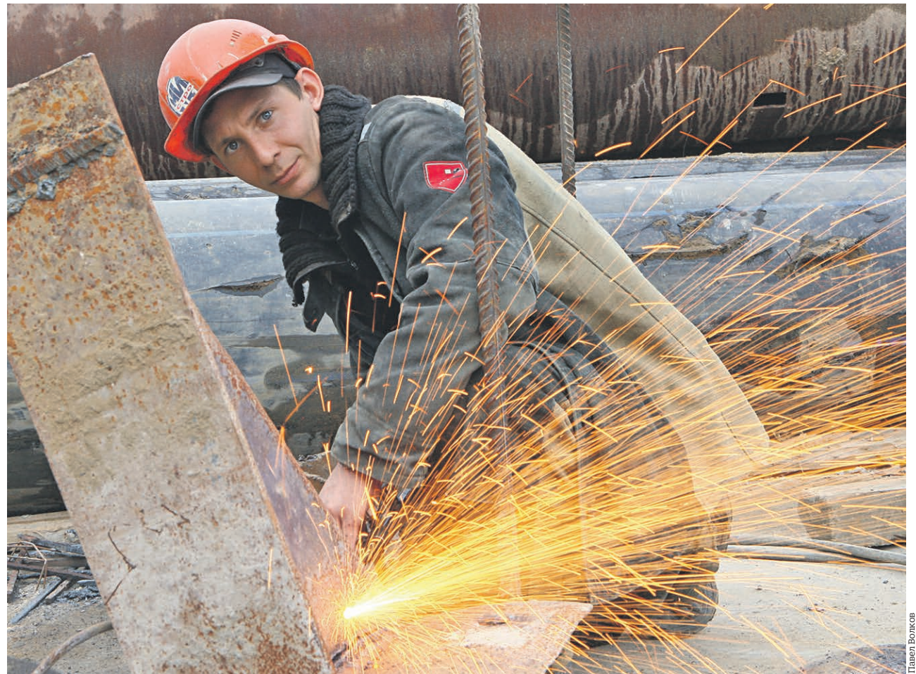
20 октября 2018 года. Метростроевец Виктор Дроганов на строительстве станции Большой кольцевой линии
