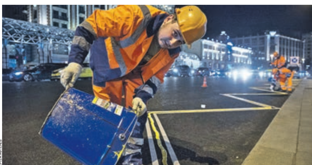
Вчера 00:02 Рабочий Михаил Голубев выливает желтый пластик возле остановки общественного транспорта на Тверской. Через три минуты треугольная разметка для автобусов была готова
