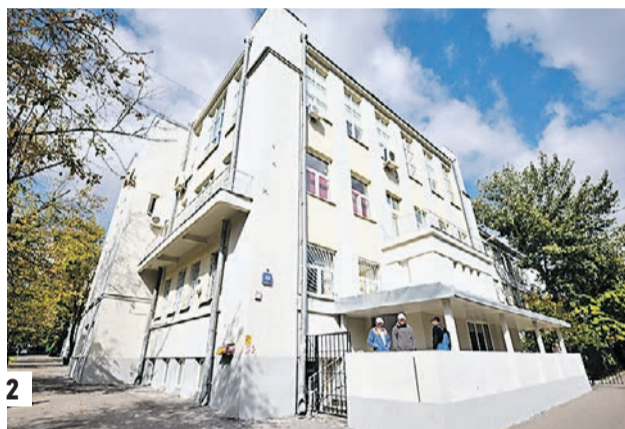
Сентябрь 2015 года. Любовь Понтанк поднялась на крышу родной школы, чтобы продемонстрировать состояние обсерватории (1). Вид на здание школы № 315 с Леснорядской улицы (2)
