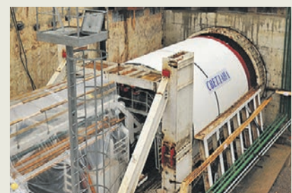
Ноябрь 2012 года. Комплекс «Светлана» приступает к проходке тоннеля в сторону «Тропарево»
