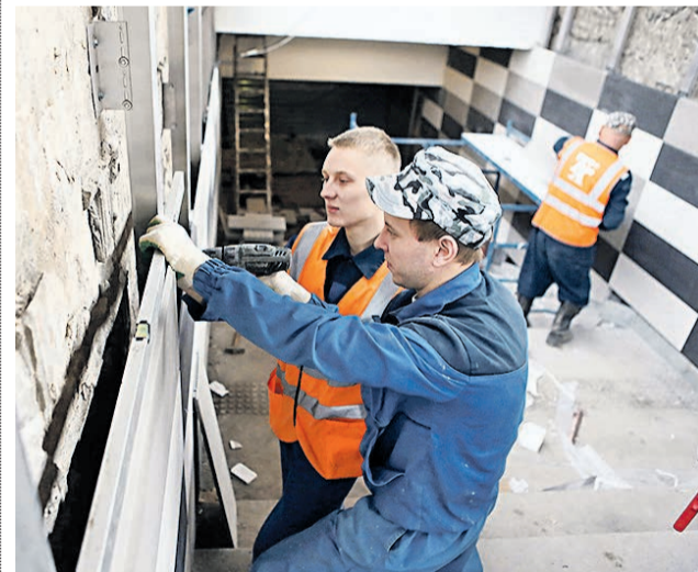
11 сентября 2015 года. Ремонт подземного перехода, прилегающего к станции метро «Пражская»
