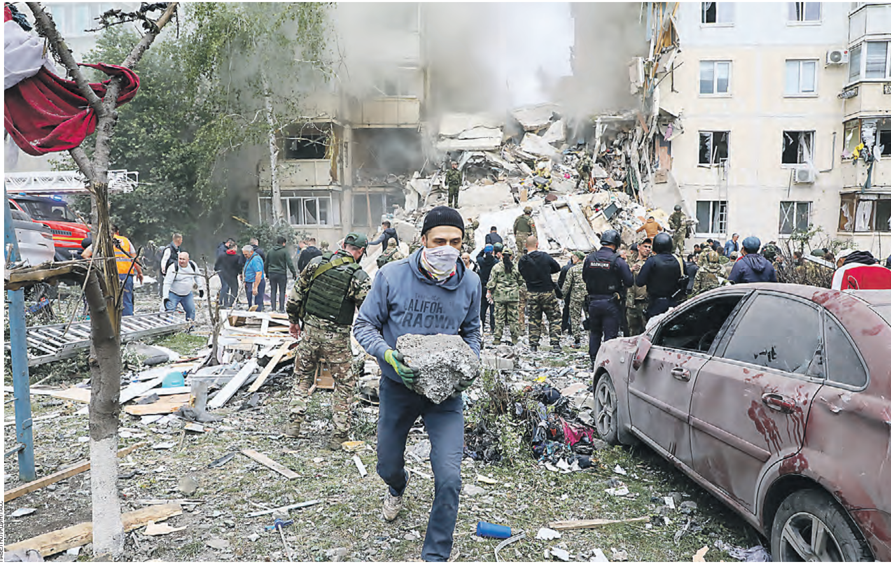
12 мая. Разбор завалов на месте обрушения подъезда жилого дома на улице Щорса в Белгороде после террористического ракетного удара ВСУ по мирным жителям
