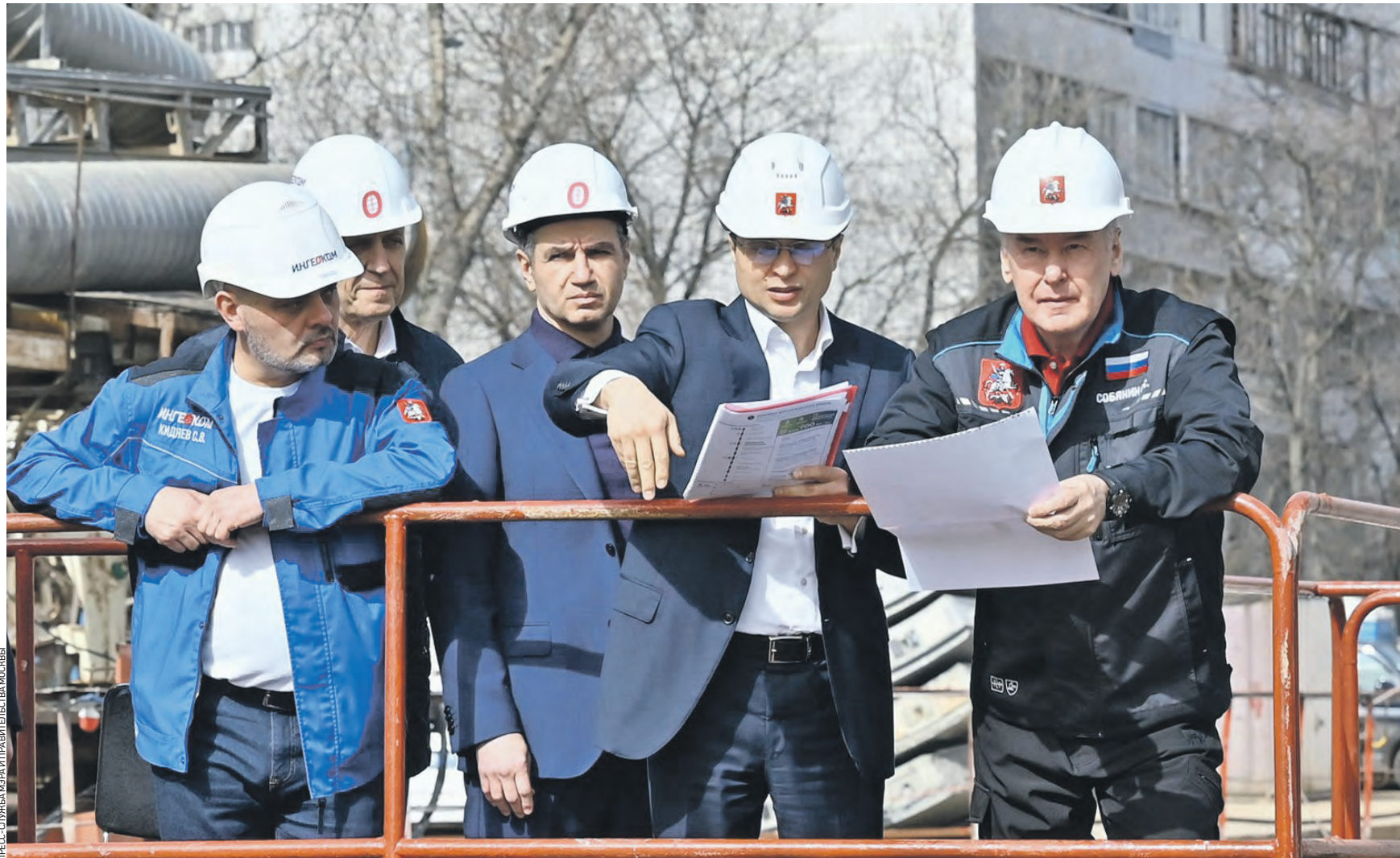
2 апреля. Руководитель столичного Департамента строительства Рафик Загруднинов (второй справа) показывает мэру Москвы Сергею Собянину (справа), как идет строительство станции «Народное Ополчение» Рублево-Архангельской линии метро. В настоящее время работы выполнены на треть
