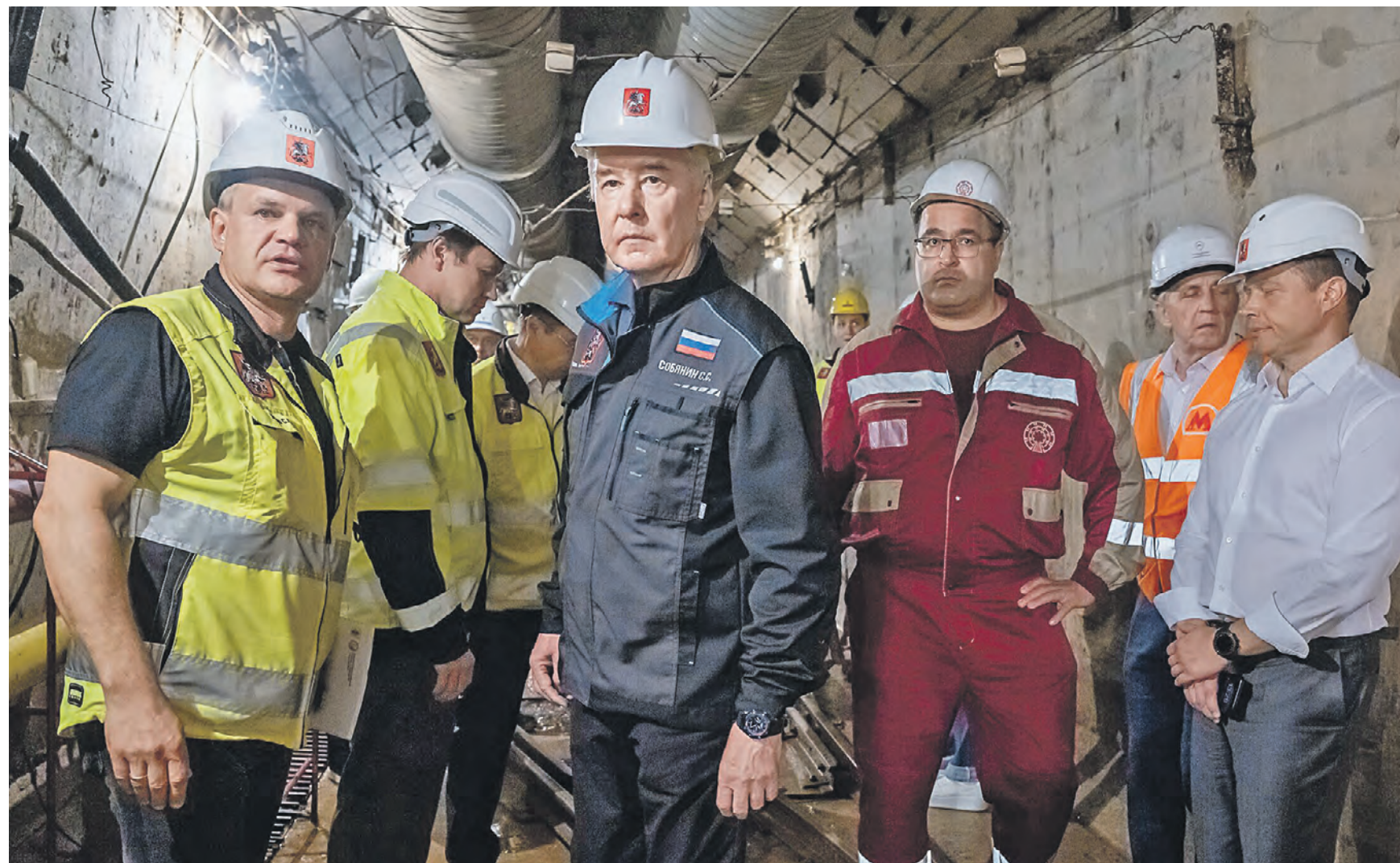
15 июля. Мэр Москвы Сергей Собянин (в центре) и генеральный директор компании-подрядчика Сергей Жуков (слева) осматривают ход строительства станции «Достоевская» на Кольцевой линии метро. Работы на законсервированной ранее станции стартовали и займут порядка пяти лет
