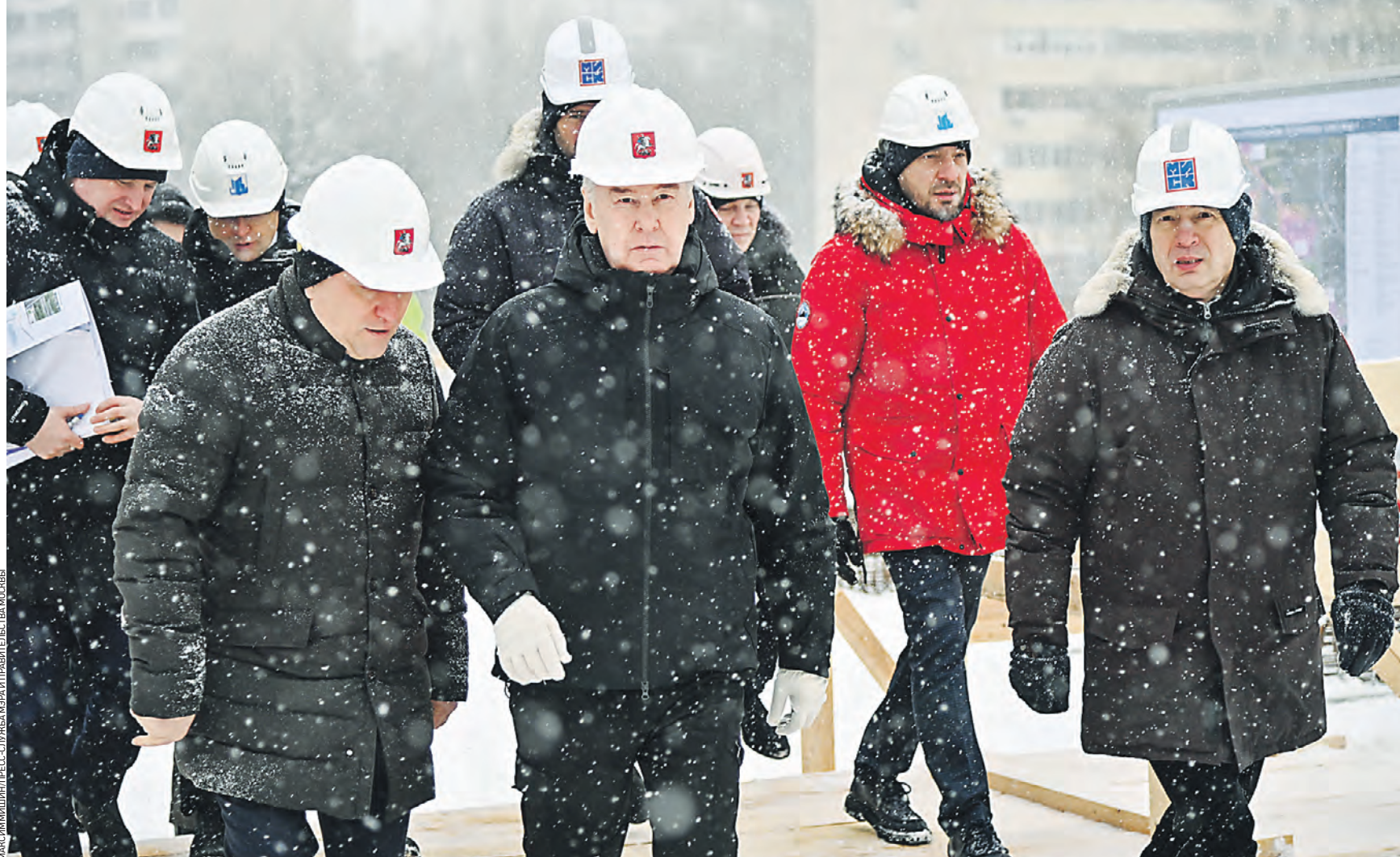
15 января. Мэр Москвы Сергей Собянин (в центре), его заместитель по вопросам градостроительной политики и строительства Андрей Бочарев (слева) и генеральный директор компании-подрядчика Фарит Хайдаров (справа) осмотрели ход сооружения нового путепровода через МЦД-1 вблизи станции «Бескудников»
