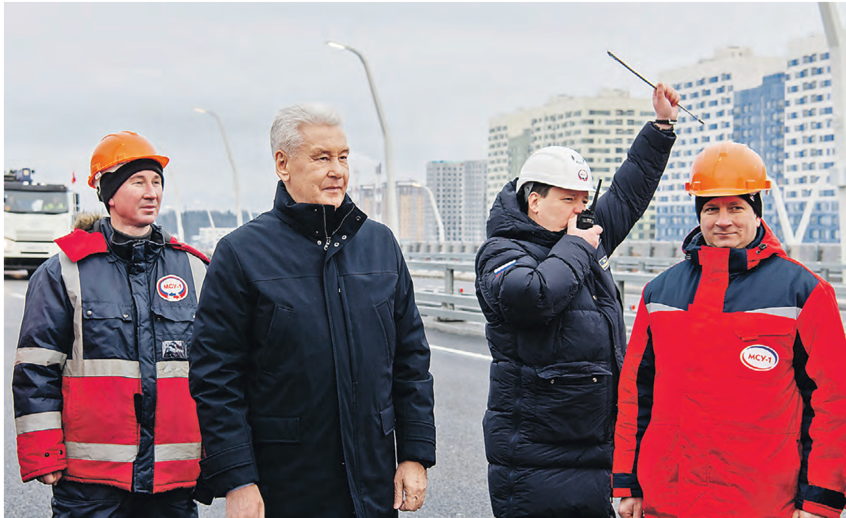
Вчера 13:14 Мэр Москвы Сергей Собянин (в центре) и генеральный директор Монолитного строительного управления № 1 Илья Зюбин (справа от него с рацией в руке) вместе со строителями запускают движение по участку Московского скоростного диаметра от Покровской улицы до Зенинского шоссе
