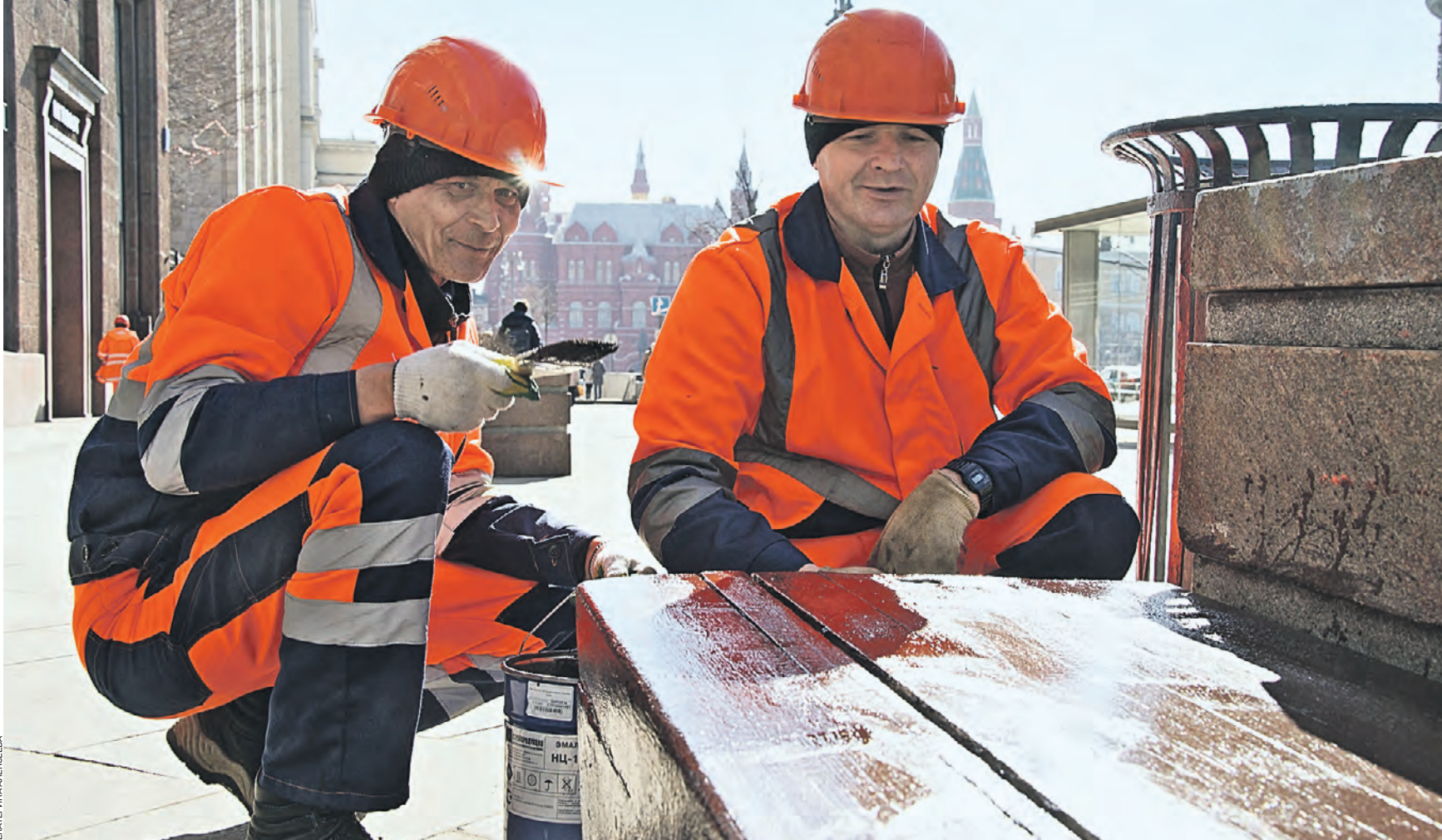
Вчера 11:08 Дорожные рабочие Константин Афонеев (слева) и Виталий Киев обновляют краску на скамейке на Тверской улице. Работы по приведению города в порядок после зимы начались уже по всей столице
