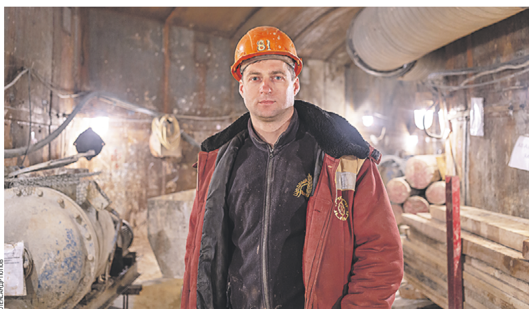
24 января 2022 года. Бригадир проходчиков Роман Фирсон контролирует ход работ на пересадке между двумя станциями «Электрозаводская». Ураган входит в состав БКЛ
