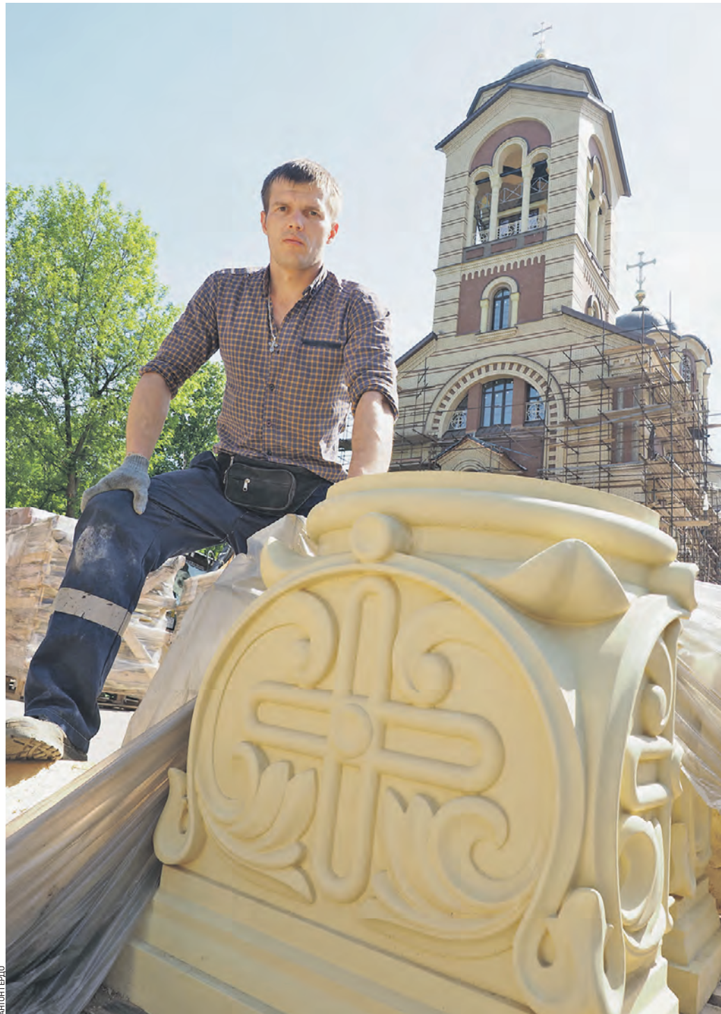
Вчера 10:45 Бригадир Николай Ермаков на строительстве храма Спиридона Тримифунтского в Коптеве. Это второй храм, который он строит. Первый — храм 12 апостолов на Клинской улице
