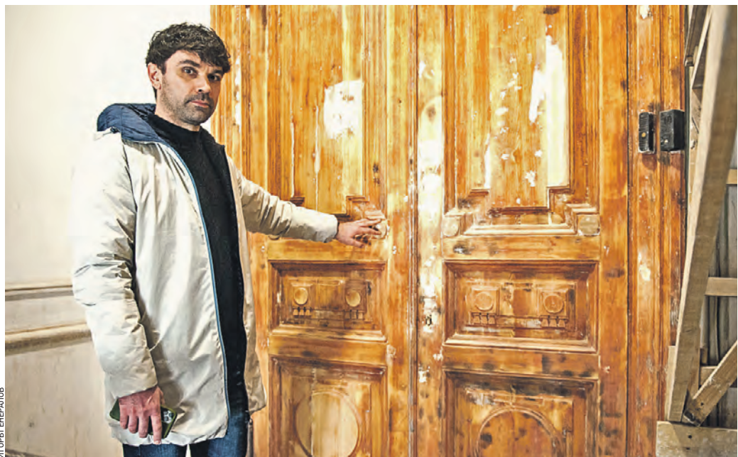
Вчера 10:14 Начальник управления по работе с объектами культурного наследия столичного Фонда капремонта Сергей Краснов осматривает дверь квартирного тамбура. На восстановление исторического вида этой двери будет потрачено десять дней
