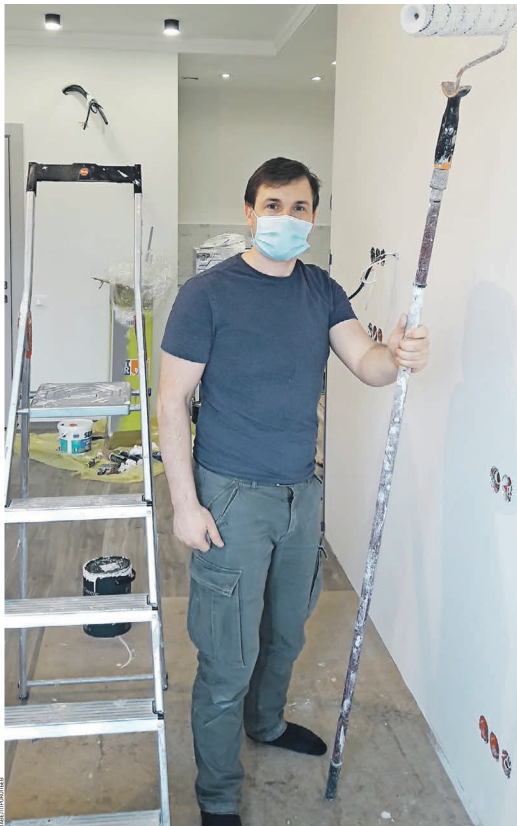
Вчера 10:45 Специалист по ремонту квартир Павел Прокопьев выполняет отделочные работы в квартире заказчика
