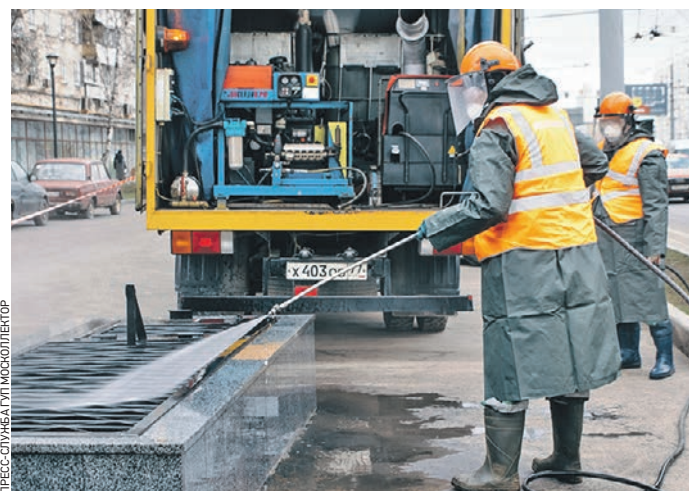
Вчера 19:37 Специалисты Москоллектора промывают шахту коллектора с помощью машины «Посейдон»
