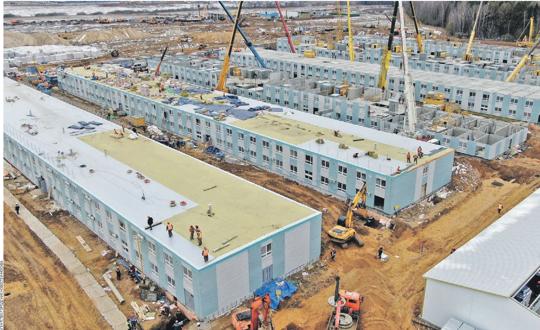
2 апреля 09:23 Строительство инфекционного медцентра в Новой Москве ведется в круглосуточном режиме. Сейчас завершается возведение сразу нескольких лечебных корпусов, а полностью больница в поселении Вороновское будет достроена в апреле
