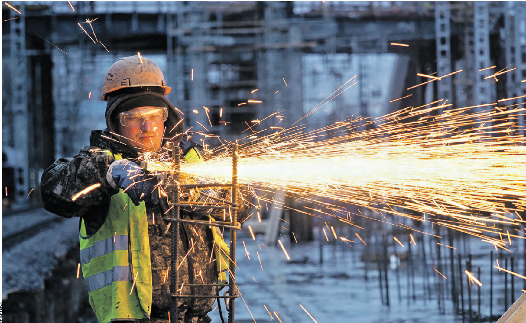
Вчера 16:13 Бетонщик Игорь Шолов подготавливает арматуру для строительства платформы Щукинская МЦД-2. Рабочие стараются все сделать в срок и как можно лучше. Некоторые из них сами будут пользоваться этой платформой
