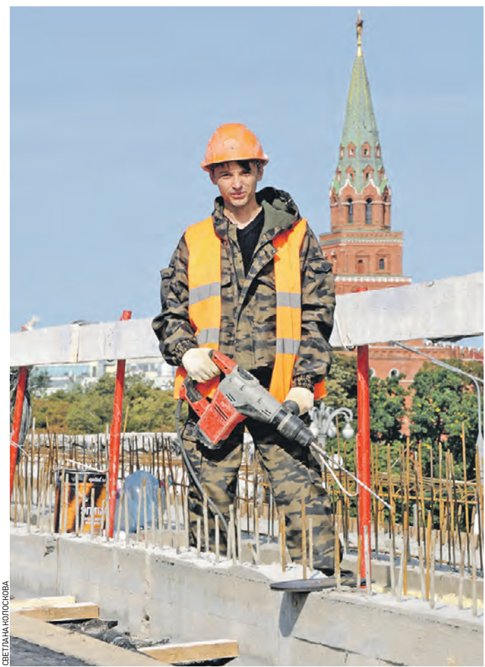
29 сентября 12:08 Строитель Дмитрий Куприенков во время работы на Большом Каменном мосту
