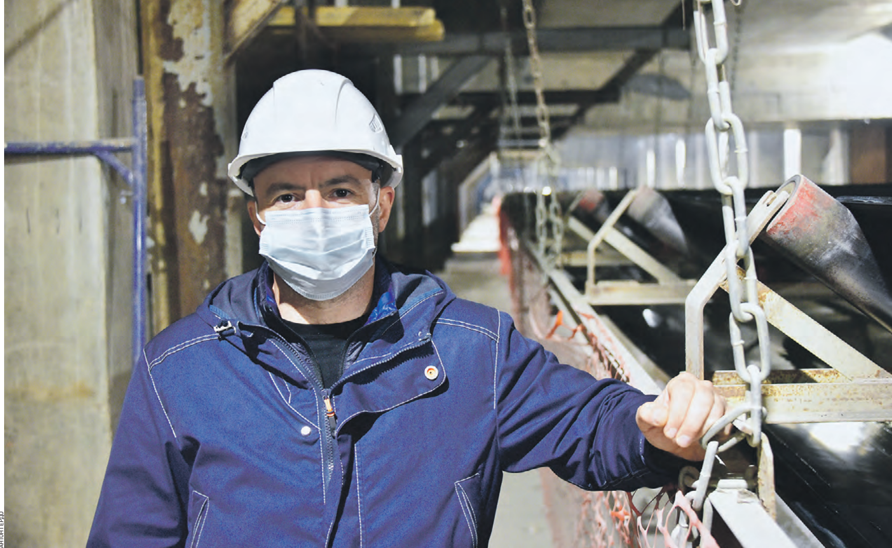
12 октября 2020 года 12:25 Заместитель главного инженера службы строительства метро компании-подрядчика Константин Цаллагов на строительстве станции метро «Терехово» западного участка Большой кольцевой линии
