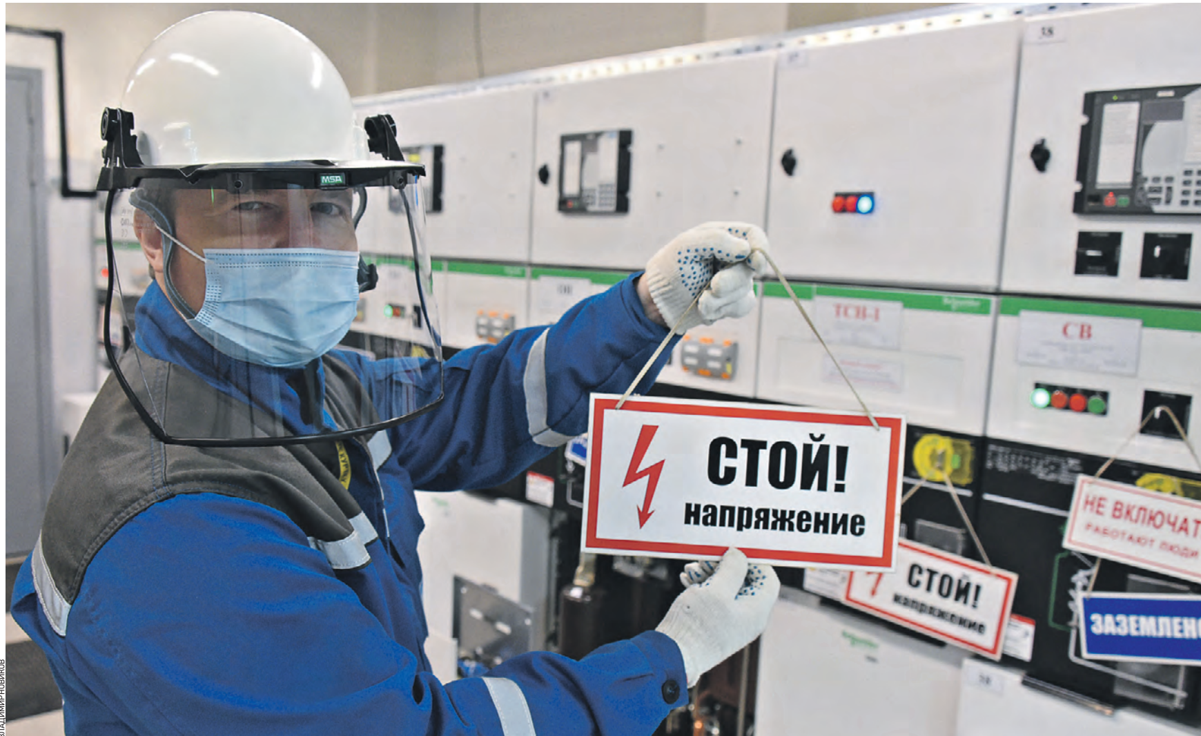
10 сентября 11:25 Главный специалист насосно-перекачивающей станции «Бирюлево-Борисовская» Михаил Никуленков возле автоматизированной системы управления технологическими процессами, которая была создана в рамках масштабной модернизации
