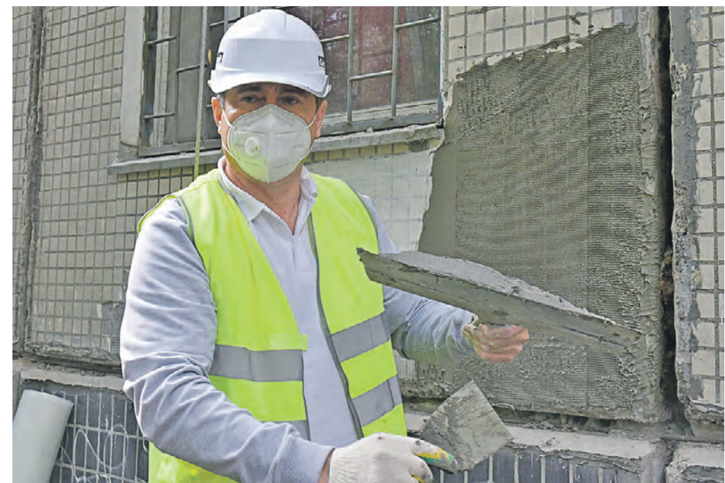
11 сентября 12:20 Технолог Григорий Мушат наносит полимерную цементную смесь на фасад дома № 10, корпус 2, по Сормовской улице
