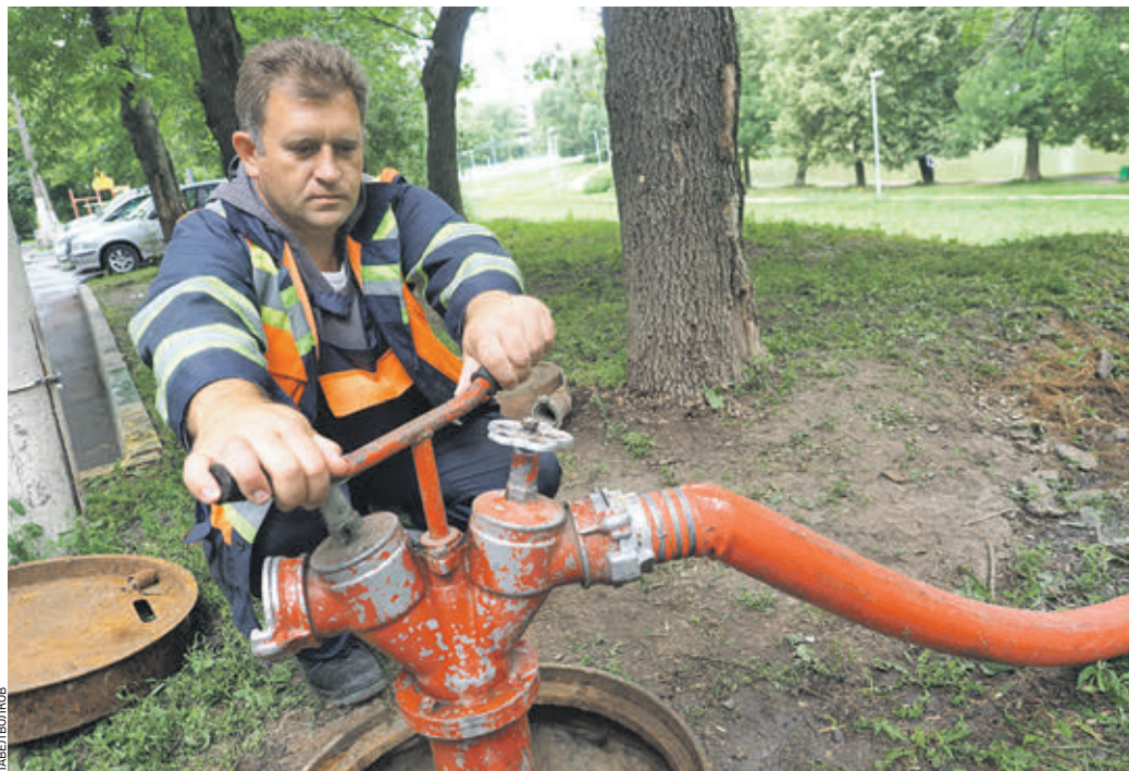
Вчера 10:22 Сотрудник ГУП «Мосводосток» Сергей Артюшин выполняет профилактические работы на Чертановской улице
