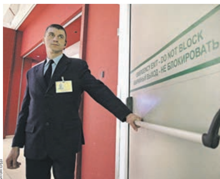
Вчера 15:30 Сотрудник службы безопасности ТРК Иван Кониевец демонстрирует работу одного из аварийных выходов на 4-м этаже торгового комплекса
