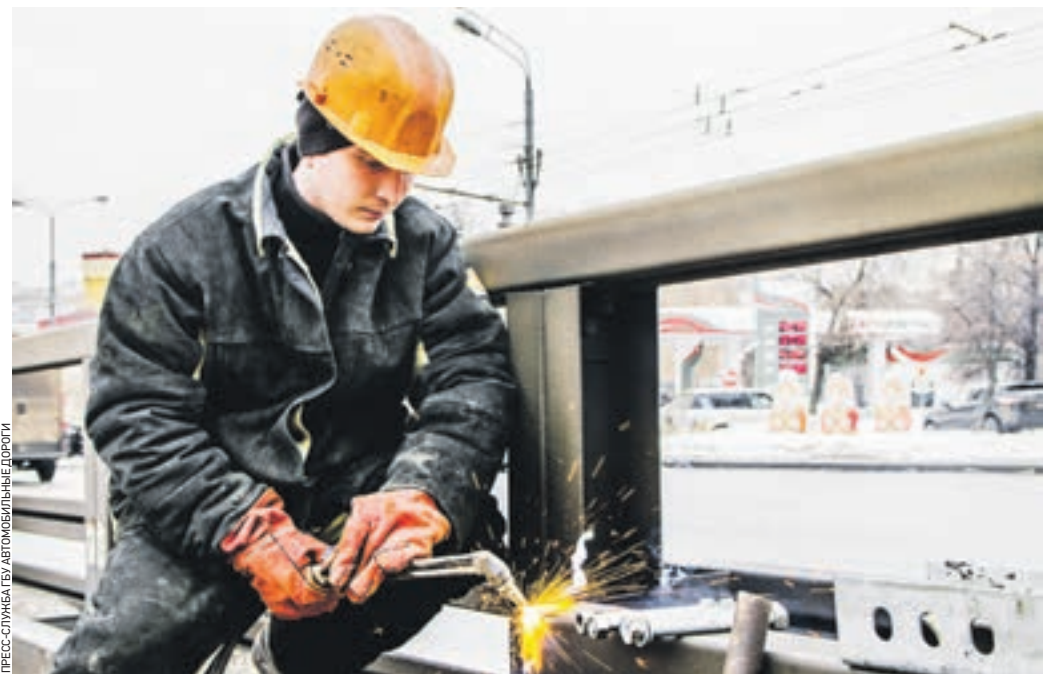
Вчера 12:17 Работник ГБУ «Автомобильные дороги» Сергей Контарев срезает поврежденную балку барьерного ограждения на Дмитровском шоссе
