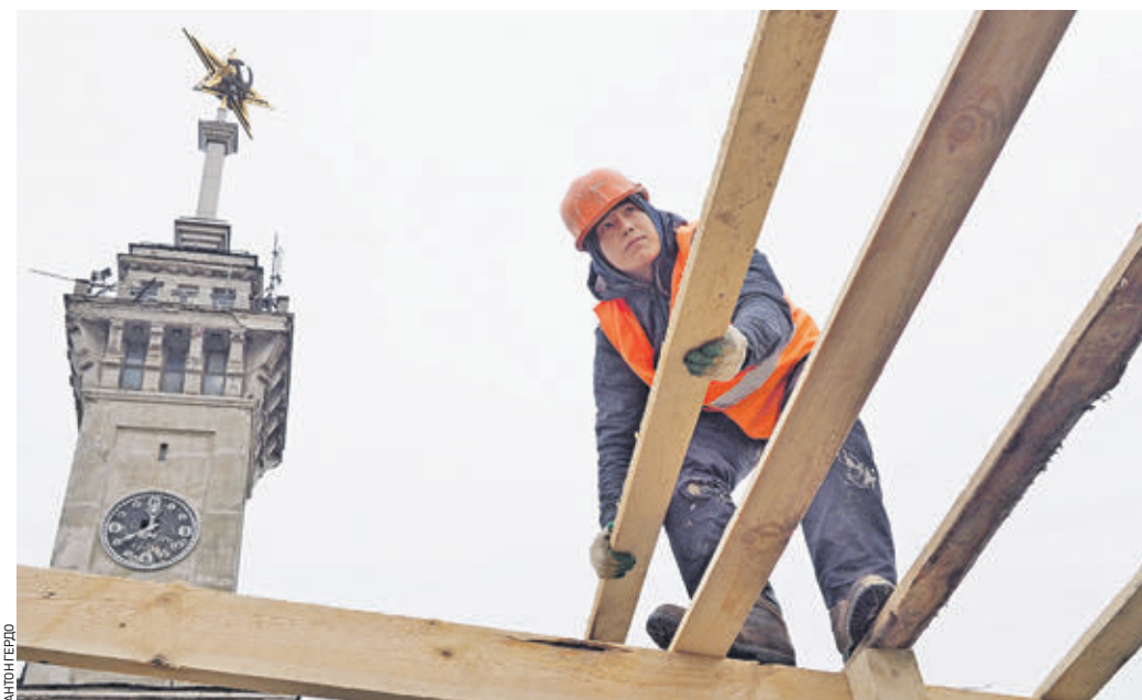
Вчера 11:10 Рабочий Артур Вартанов во время установки лесов на здании Северного речного вокзала. Сейчас здесь проводят противоаварийные работы
