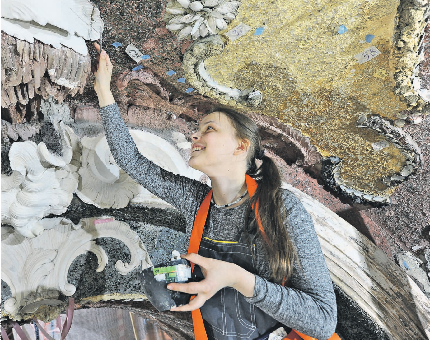
8 мая 2018 года. Реставрация грота в усадьбе Кусково. Студентка строительного техникума Тамара Шестакова на практике занимается расшивкой и подмазкой трещин
