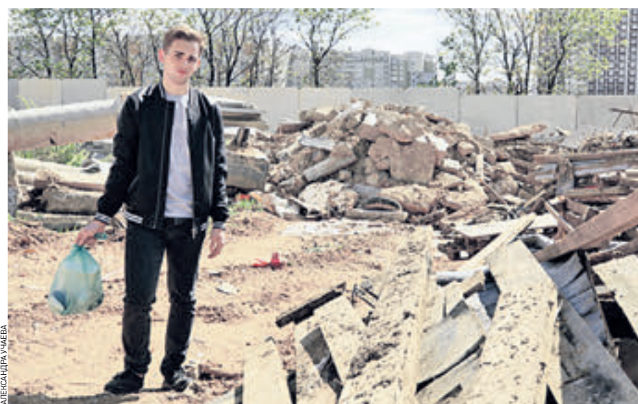
22 мая 15:00 Николай Петров жалуется, что под окнами его дома на Варшавском шоссе расположена свалка строительного мусора
