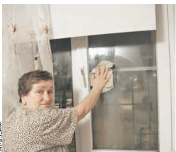
Вчера 13:50 Тамара Моисеева демонстрирует запотевшие от сильного пара стеклопакеты. От высокой влажности квартира буквально погибает
