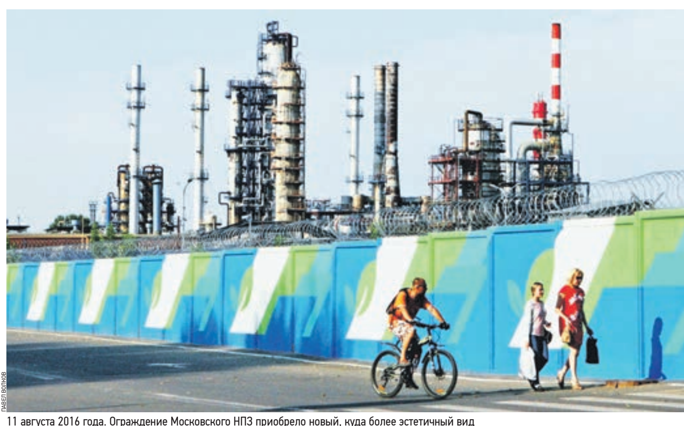
11 августа 2016 года. Ограждение Московского НПЗ приобрело новый, куда более эстетичный вид
