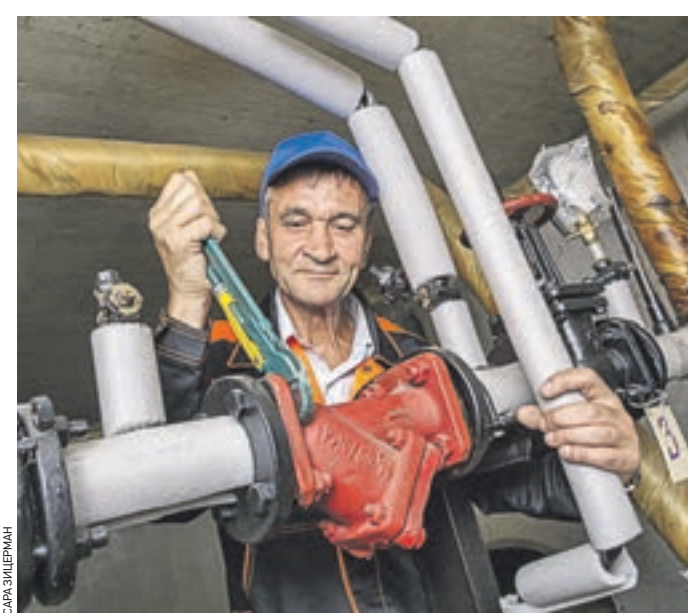
5 июня 2016 года 11:00 Слесарь «Жилищника района Марьино» Анатолий Барийщев проверяет работу теплового узла в подвале
