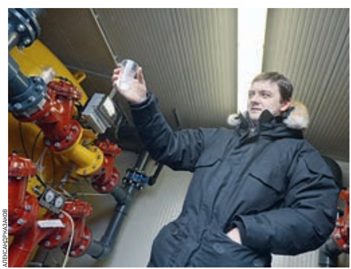
Вчера 15:33 Главный инженер Мосводоканала по новым округам Дмитрий Мишин пробует воду из местных скважин
