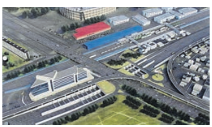
Манет тоннеля на пересечении Щелковского шоссе, двух разворотных эстакад — участок Северо-Восточной хорды
