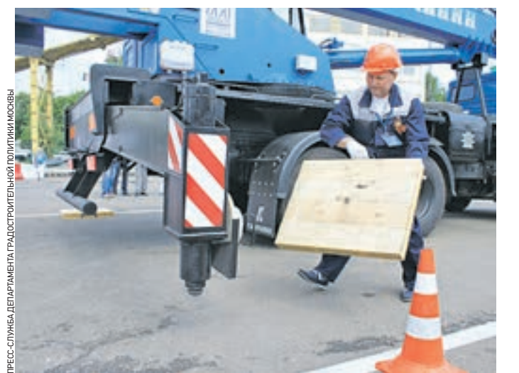
Вчера 14:10 Машинист автокрана Сергей Золин устанавливает фиксаторы перед началом тестового задания
