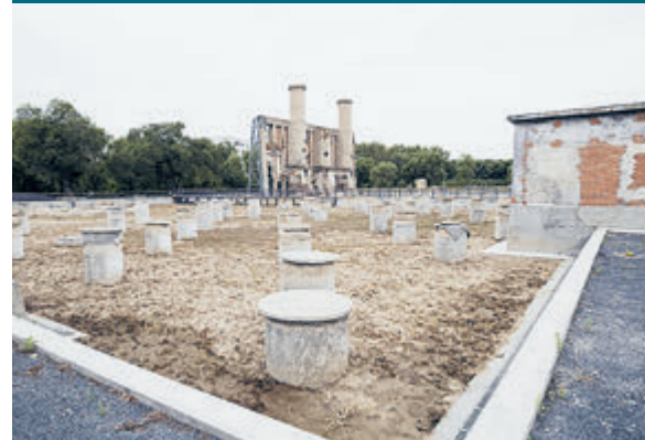
Развалины котельной установки «отряда 731» в городе Харбине.
