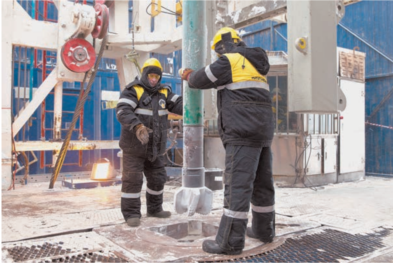
За дело берутся операторы буровой установки.
