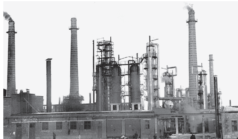
Гидроочистка дизельных топлив на Новокуйбышевском НПЗ.
