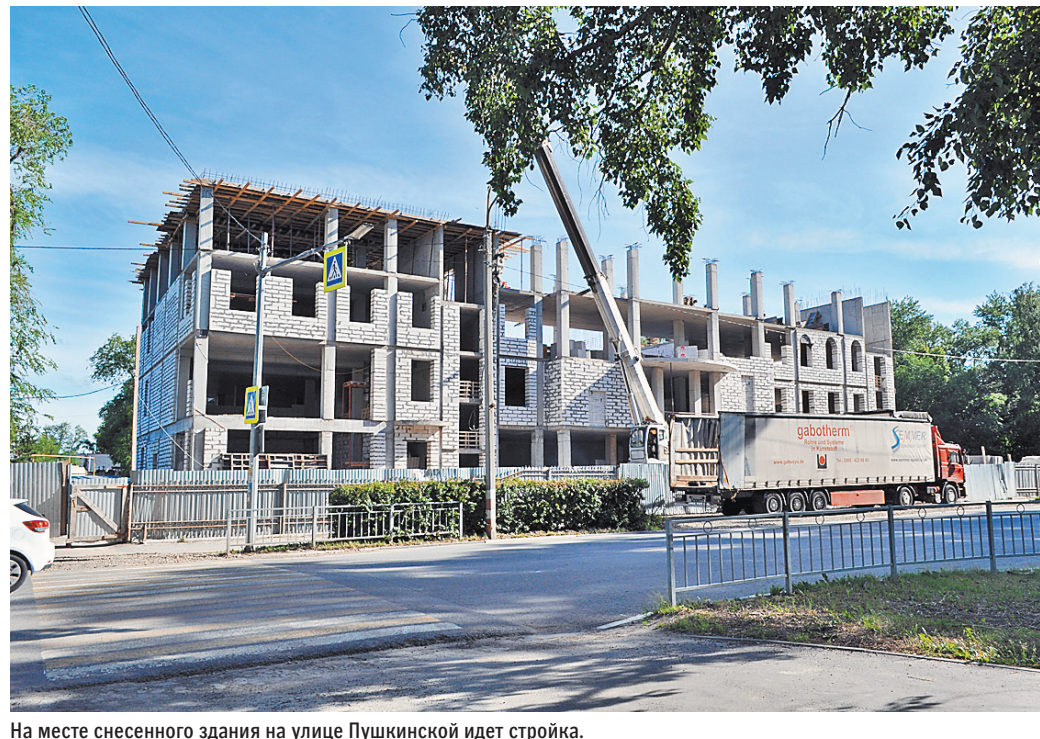
На месте снесенного здания на улице Пушкинской идет стройка.
