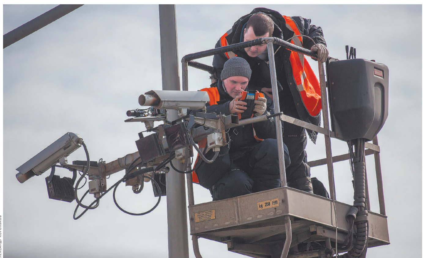
Даже угол наклона камеры влияет на точность вычисления скорости проезжающего автомобиля.
