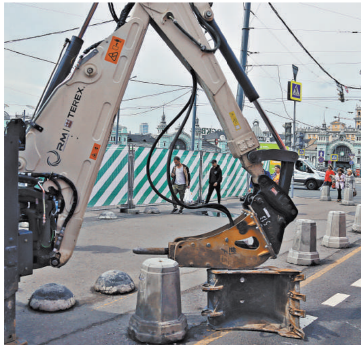
Большая часть площади уже огорожена заборами. Впереди — масштабные ремонтные работы
