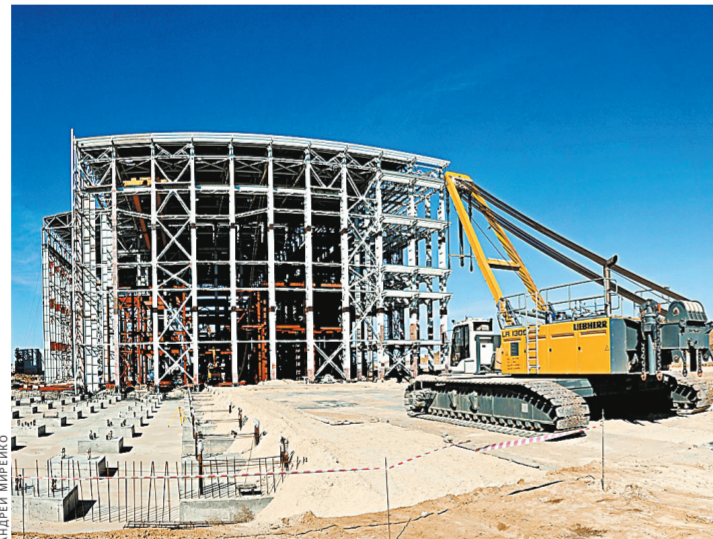
«ЕвроХим» ведет в Котельниково беспрецедентное для современной России строительство.
