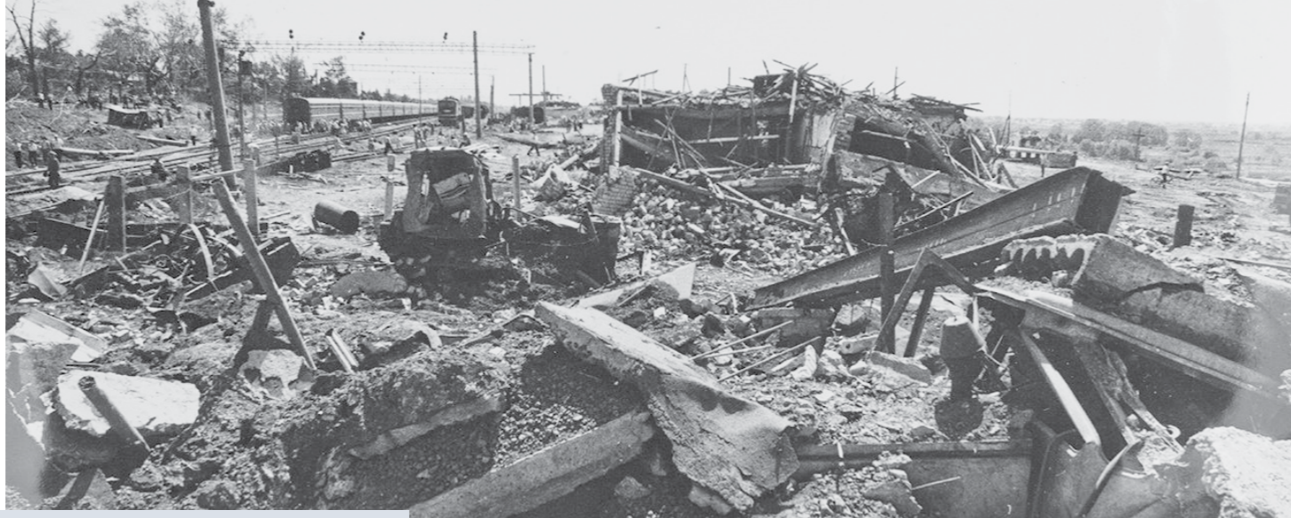
Здание больницы, которое было разрушено взрывом. Оно так и не было восстановлено.
