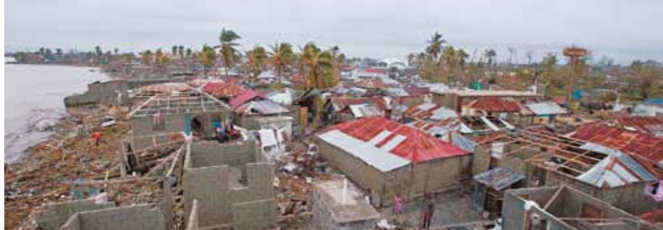
Ураган «Мэттью» прошелся по Гаити, оставив ужасающие разрушения.
