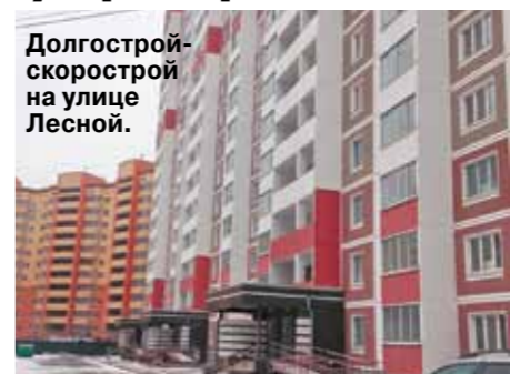
Долгострой-скорострой на улице Лесной.
