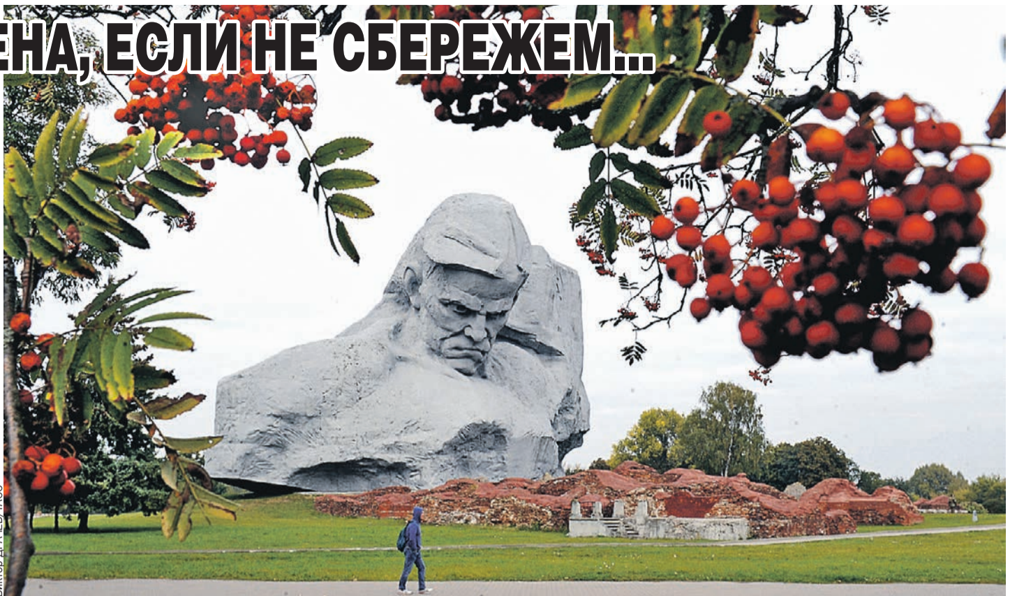
Центральный монумент мемориального комплекса - «Мужество». Голова воина на фоне развевающегося знамени состоит из двухсот блоков, поднимающихся в высоту на тридцать метров.
