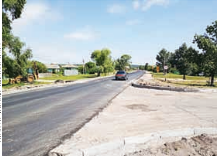
Дорожное полотно уложено. В ближайшее время будет устроена обочина, нанесена разметка, установлены знаки.
