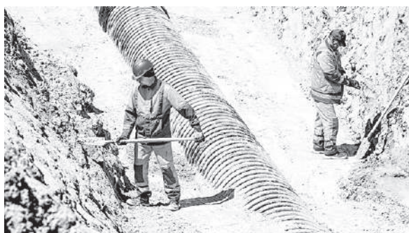
Компания обеспечит микрорайон дорожной и инженерной инфраструктурой.
